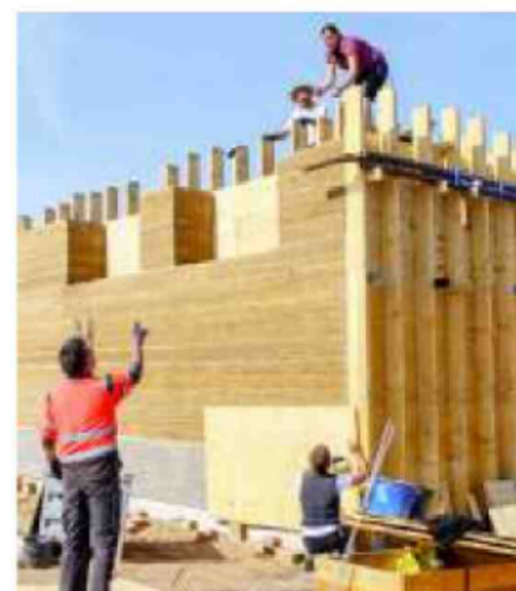
Der Rohbau des aus Lehm gefertigten Informationszentrums FOTO: DPA
